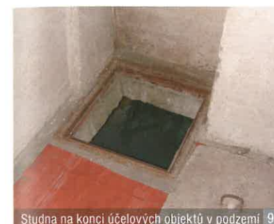
Studna na konci účelových objektů v podzemí
