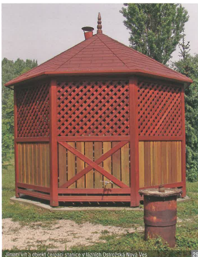
Jímací vrt a objekt čerpací stanice v lázních Ostrožská Nová Ves
