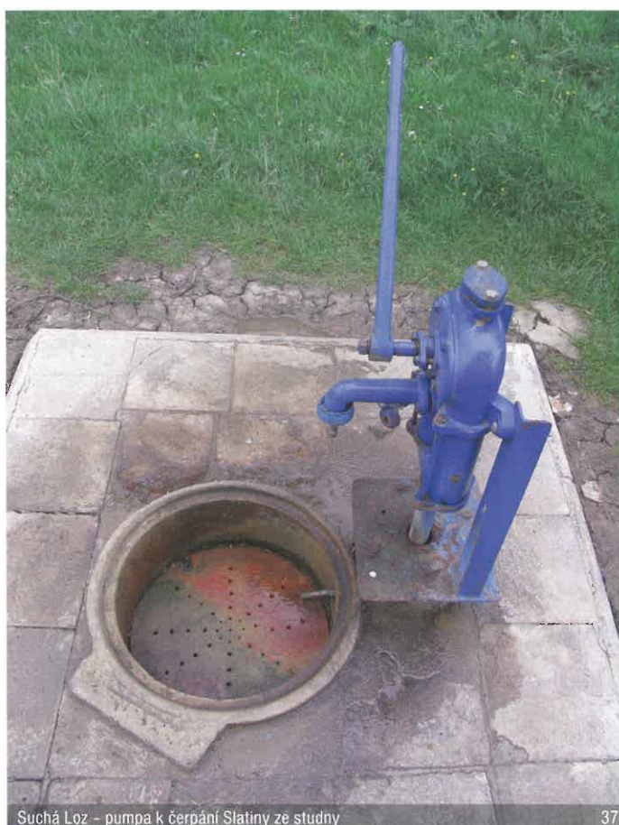
Suchá Loz – pumpa k čerpání Slatiny ze studny
