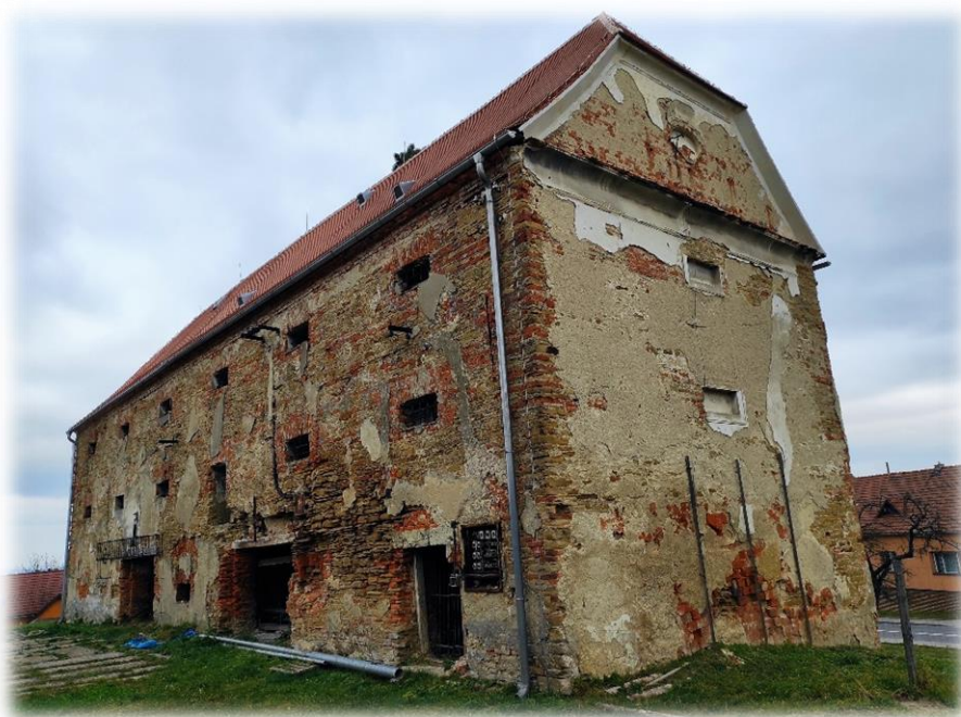
Obnovená střecha sýpky v Kelči
