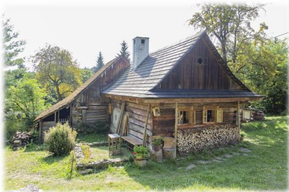
Dům č. p. 74 se sušárnou v Rokytnici u Vsetína (obnova získala uznání Lidová stavba roku 2019)
