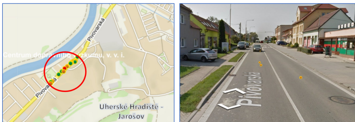
Obrázek 11 Komunikace II/497 – Uherské Hradiště – místní část Jarošov (Zlínský kraj)
