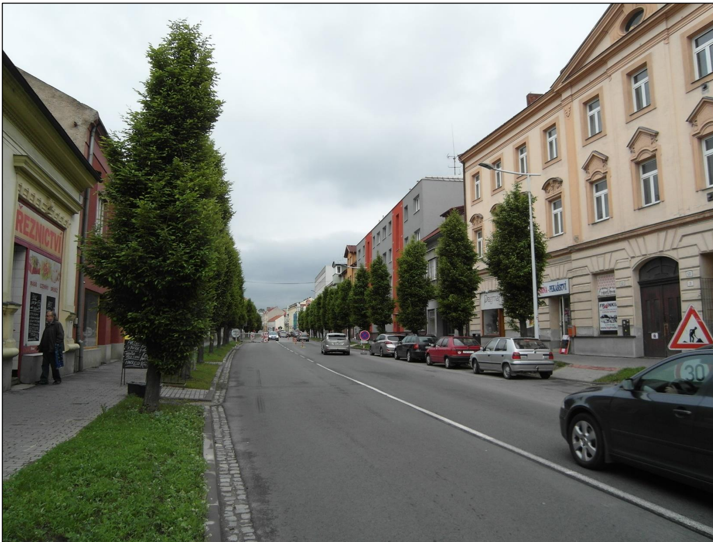
Obr. 9: Fotodokumentace zástavby v okolí kritického místa priority I v ulici Palackého v Holešově, komunikace II/438
