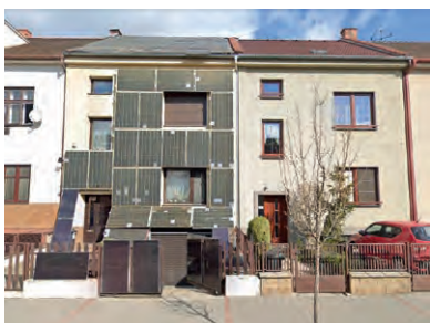
Negativní příklad instalace FVS na plášť domu v Brně-Židenicích, bez vztahu k charakteru objektu či místa, narušuje celkovou kompozici objektu a významně se uplatňuje ve vnímání širšího území, viditelnost FVS v blízkých i dálkových pohledech, kontrastní řešení vůči podobě okolní zástavby.
