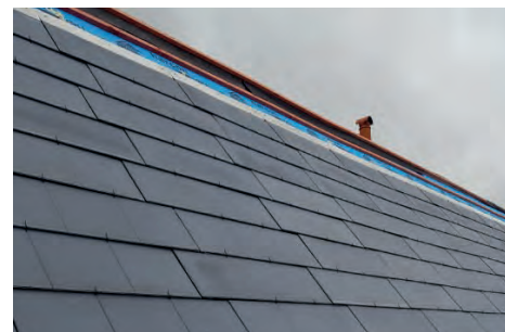
Břidlicová střešní krytina s integrovanou fotovoltaickou technologií
