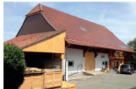
Fotovoltaické tašky terakotového vzhledu na venkovské farmě, vesnice Ecuwillens
