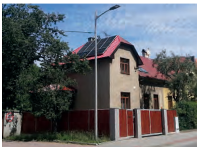
Valašské Klobouky: negativní příklad instalace FVS na fasádě a střeše, bez vztahu k charakteru objektu či místa, narušuje celkovou kompozici objektu, viditelnost FVS v blízkých i dálkových pohledech, kontrastní barevnost vůči okolním plochám, rušivé odrazy / odlesky na okolní objekty.
