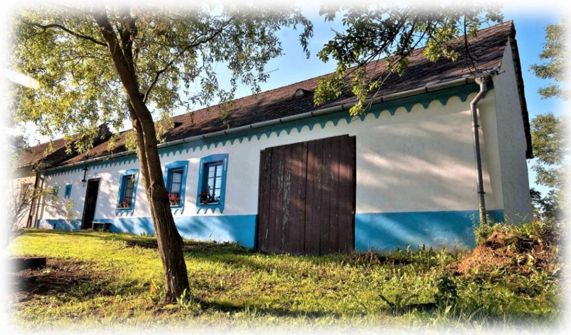
Stavení č. p. 77, Bystřici pod Lopeníkem (obnova získala uznání Lidová stavba roku 2018)
