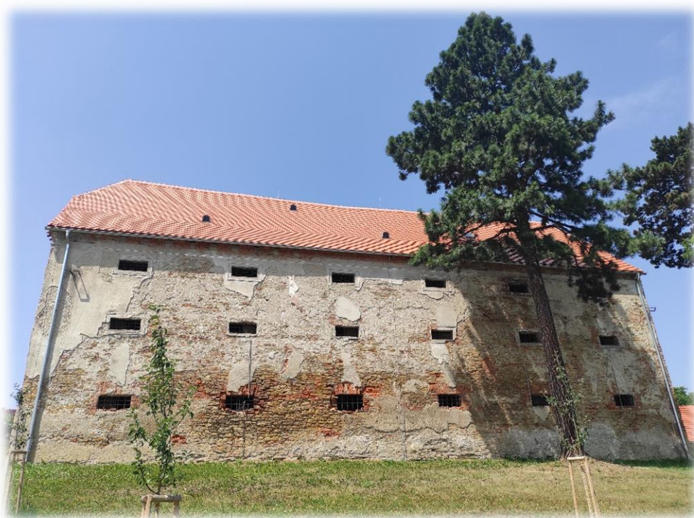
Obnovená střecha sýpky v Kelči
