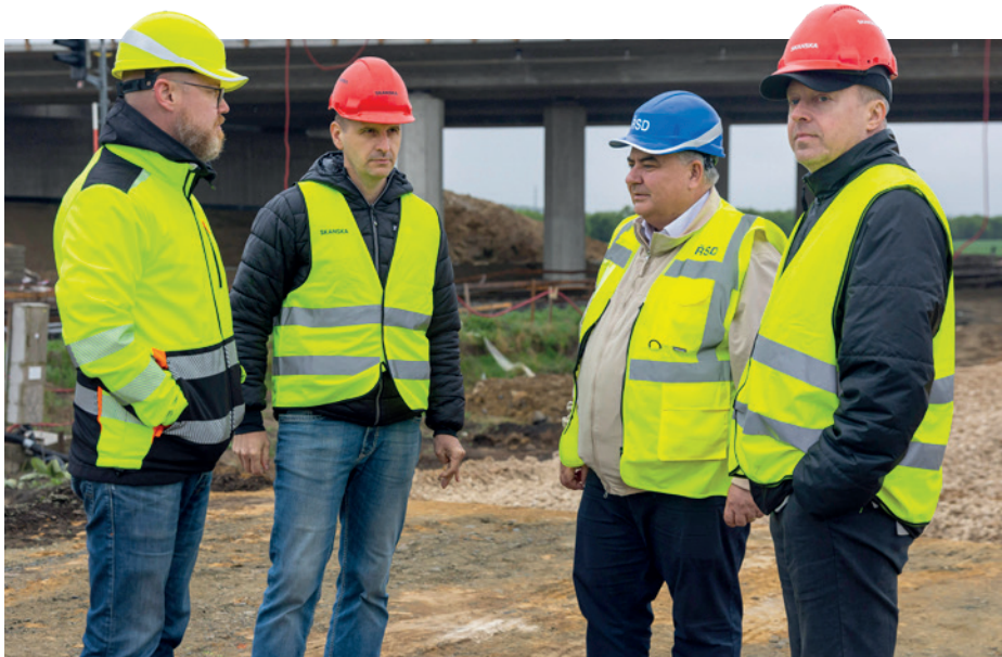
STAVBA DÁLNIC. Hejtmán Radim Holíš a náměstek pro dopravu Radek Doležel se byli podívat na pokračující výstavbu dálnic ve Zlínském kraji. Pokud vše půjde dobře, na konci roku se otevře dálnice D49 v úseku Hulín-Fryšták a D55 na Slovácku.
