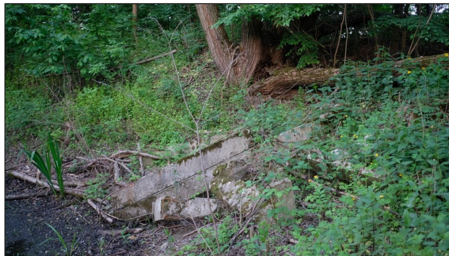
Obr. 4: Hráz zbudovaná z betonových panelů mezi plochou 3 a starým náhonem.
