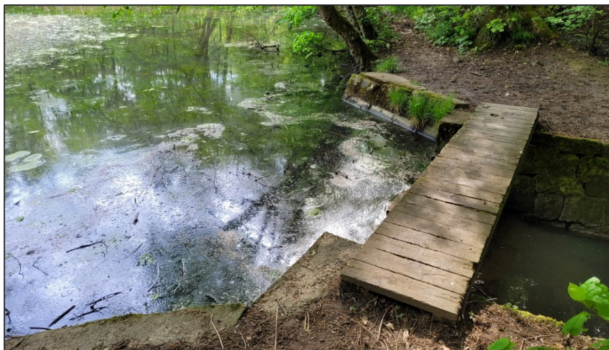
Obr. 6: Bezpečnostní přeliv rybníka přemostěný dřevěnou lávkou (ústí do obtokové stoky).
