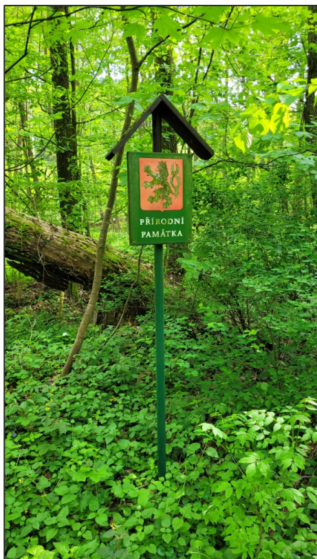
Obr. 10: hraničník ve zhoršeném technickém stavu.
