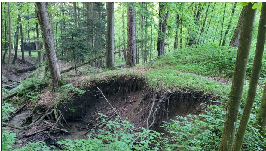
Obr. 7: Vymletý břeh obtokové stoky v ochranném pásmu památného stromu (borovice ve středu obr.).
