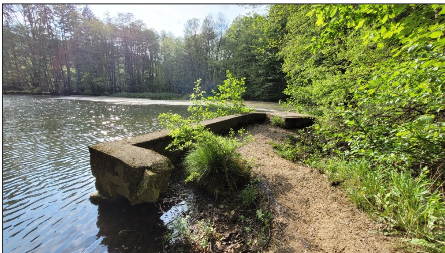
Obr. 5: Technická část hráze rybníka včetně technologické šachty; vzadu je patrné relativně omezené litorální pásmo a za ním plocha 2b (jasanovo-olšový lužní les).
