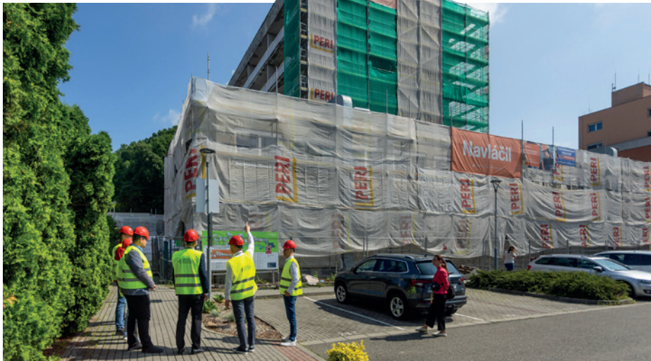
INTERNA KNTB. Budova interního oddělení Krajské nemocnice T. Bati ve Zlíně dostane do konce listopadu kompletní zateplení a nová okna. Podívat se na průběh prací v rámci kontrolního dne vyrazili na začátku června i hejtman Radim Holíš a náměstkyně pro zdravotnictví Olga Sehnalová.
