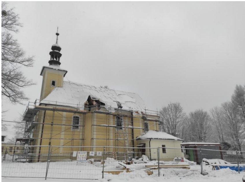
Obnova střechy kostela Nanebevzetí Panny Marie ve Valašské Bystřici v roce 2023
