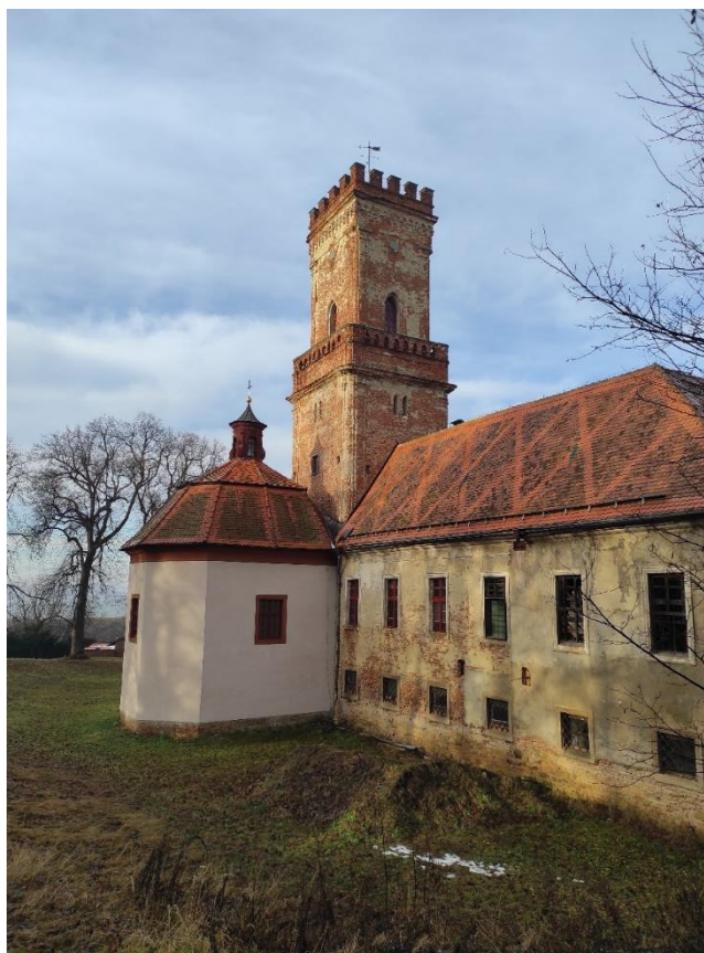
Zámek Dřínov – realizovaná obnova oken v 2 NP. jihovýchodního nároží zámku v roce 2023
