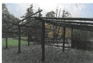
POHLED NA HRŠEBEN
