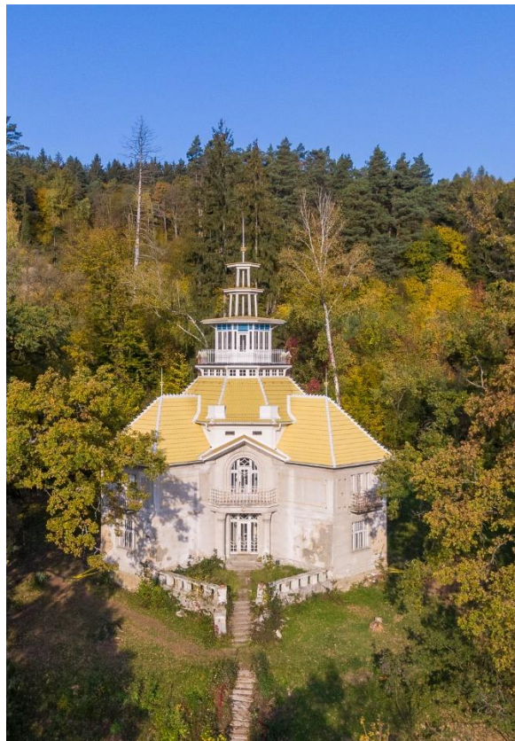
Obnovená střecha vily Kancnýřky v Luhačovicích
