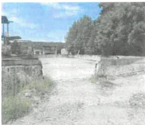
Obrázek 5. Záchytná betonová vana/ zpevněná plocha
