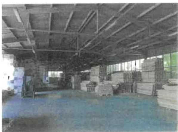
Obrázek 9. Ocelová hala HARD/interiér
