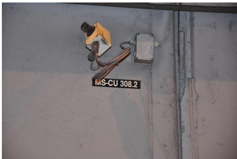
LAT – Ultrazvukové měření proudění vzduchu
