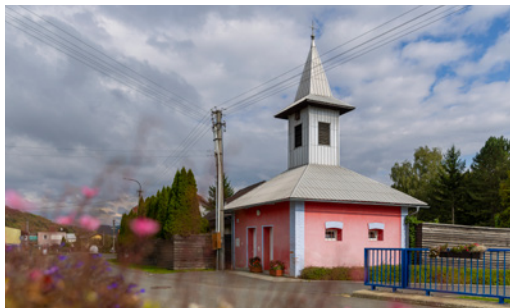
↑ HASIČSKÁ ZBROJNICE. Výraznou stavbou v obci je hasičská zbrojnice, která před pár lety prošla rozsáhlou rekonstrukcí.
