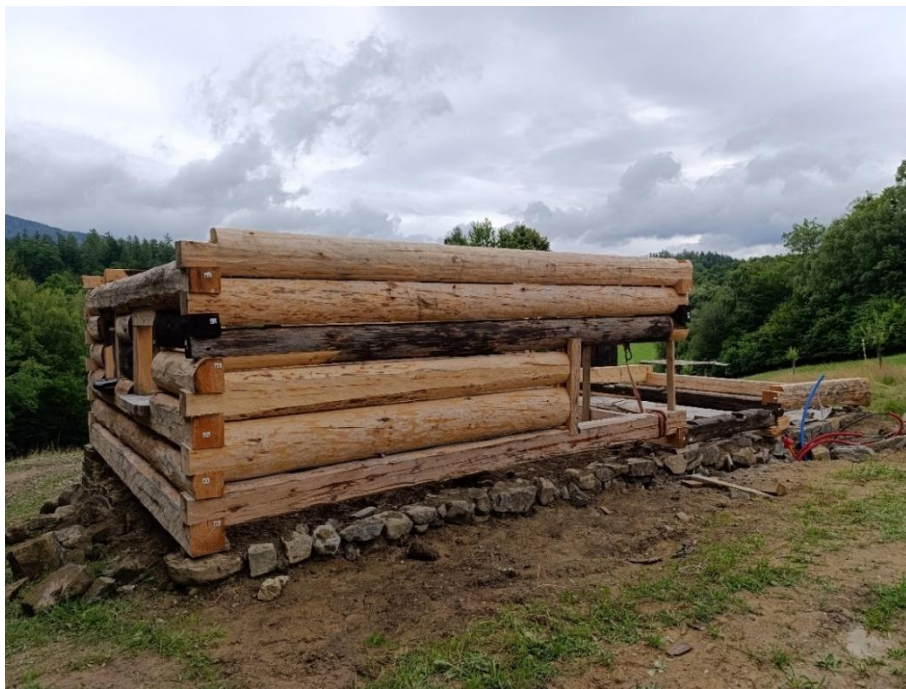
Výstavba areálu Kolibiska
