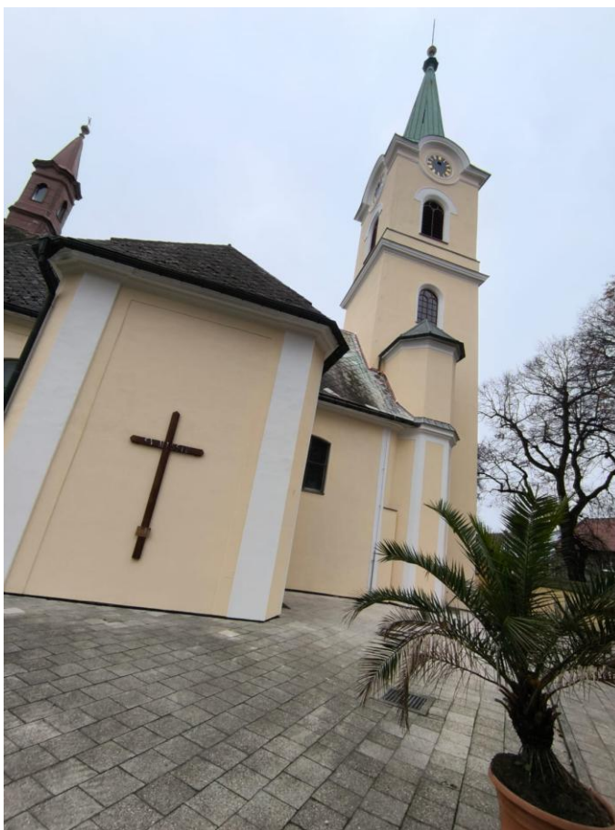
Obnova fasády, oken a okenic věže kostela sv. Jakuba Staršího v Břestu
