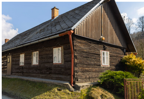
↑ HISTORIE. Hned několik dřevěných stavení ukazují podobu typické lidové architektury.
