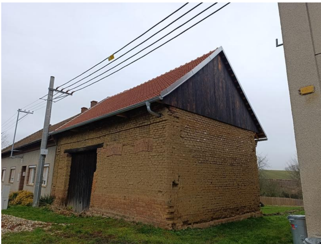
Obnovená střecha a krov stodoly v Roštíně
