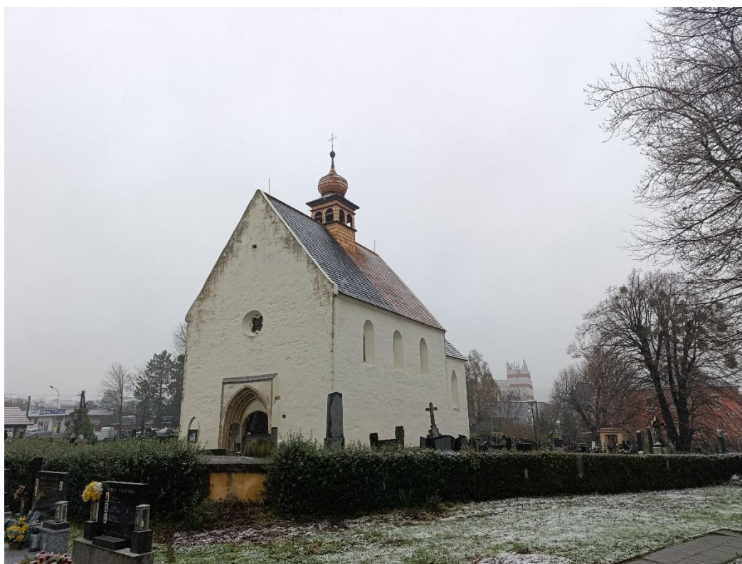
Obnova střechy kostela sv. Jakuba Většího v Tečovicích
