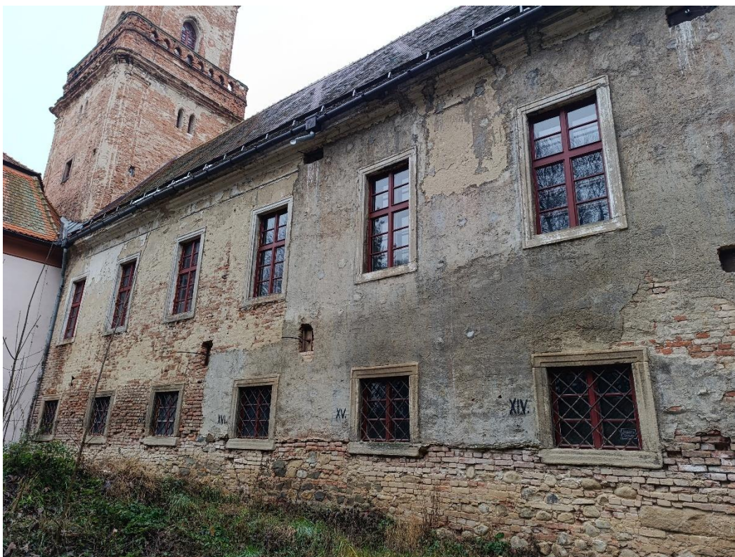
Obnova oken na zámku Dřínov
