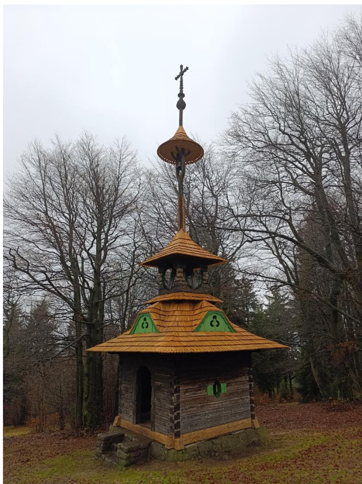
Obnovená zvonička na Pustevnách
