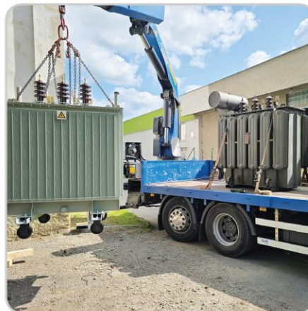
Výměna transformátoru
